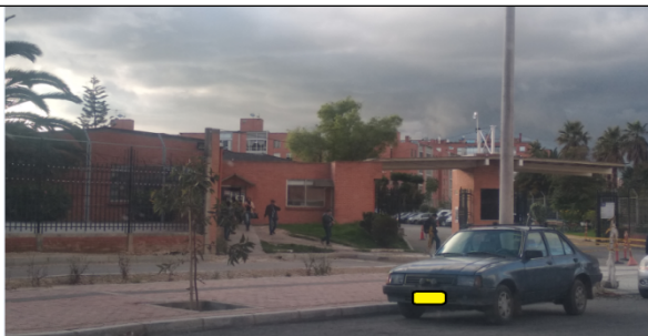
Foto No. 1. Fachada del predio
