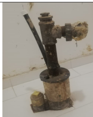
Foto No. 6. Boca del pozo pz-08-0032
